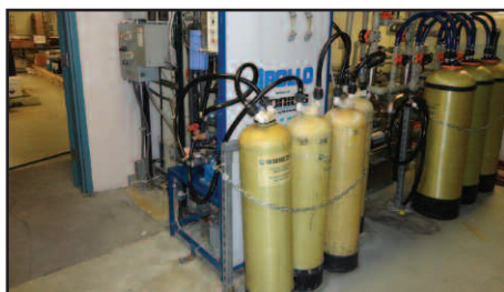
Iconics DI Water System
