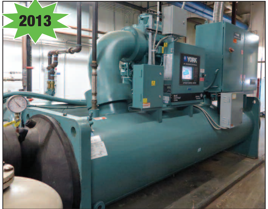
York-Johnson 390 H.P. / 500 Ton Turbo Chiller
