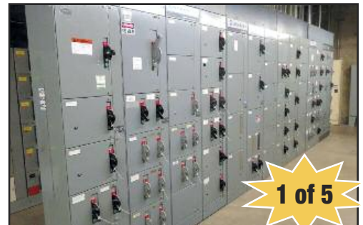
Allen Bradley Centerline 2100 M.C.C.
