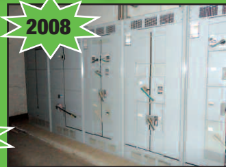
Siemens 4000 Amp Switch Gear
